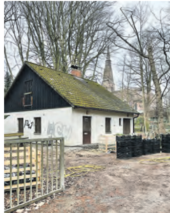
Das Betriebsgebäude eignet sich hervorragend als Standort für ein öffentliches WC.
